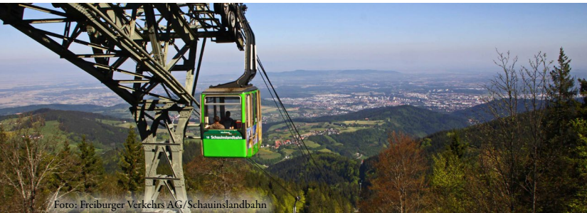
Foto: Freiburger Verkehrs AG / Schauinslandbahn
